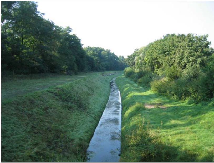
Typische Ansicht des in Betonsohlschalen ausgebauten Schmutzwasserlaufes vor der Umgestaltung
